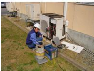
冷媒ガスチャージ作業
