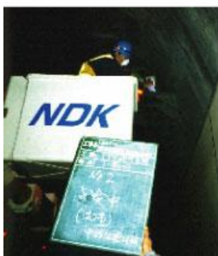
高所作業車によるトンネル内 照明灯点検作業
