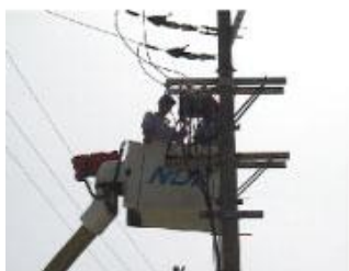
高圧気中開閉器の取り替え作業
