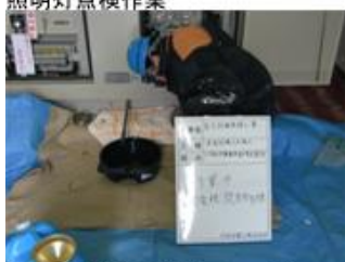
非常用燃料発電機オイル交換
