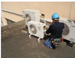
エアコン室外機設置作業
