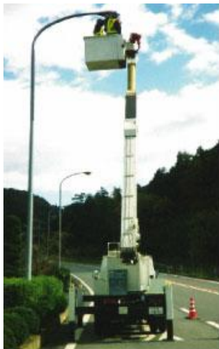
高所作業車によるハイウェイ灯 点検作業
