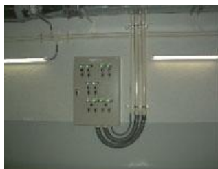
盤への配管・配線
