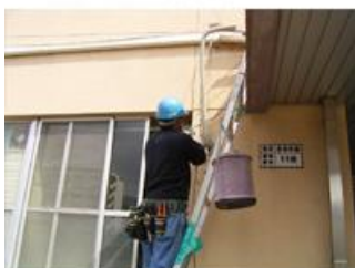
エアコン器具配管作業
